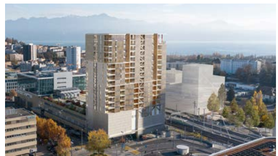
Malley Phare à Prilly est la première tour en structure bois de Suisse romande avec façades actives en photovoltaïque.
